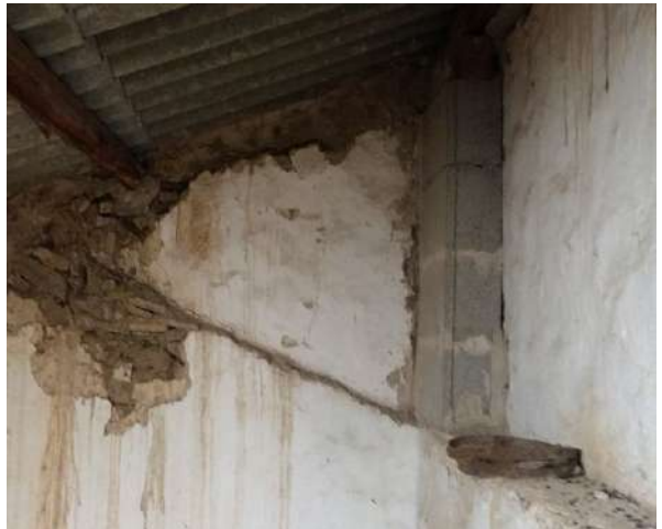
Sottotetto ad una falda con lastre in "eternit"
