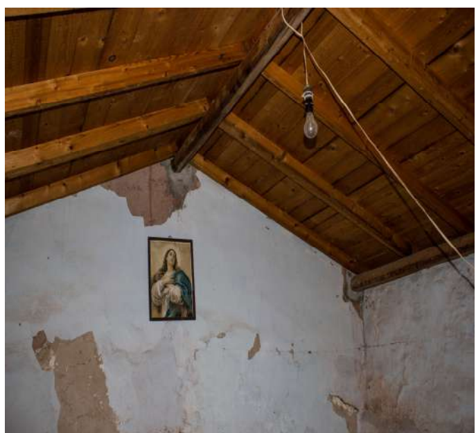
sottotetto a due falde
