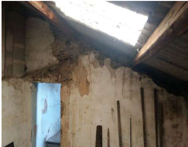
Sottotetto ad una falda con lastre in "eternit"
