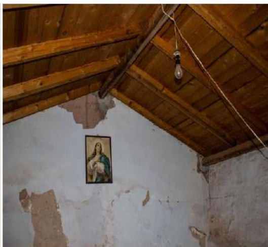
sottotetto a due falde
