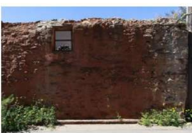
fdettaglio fronte principale (nord-est)
